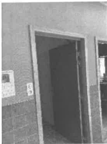
Porte escalier encloisonné
