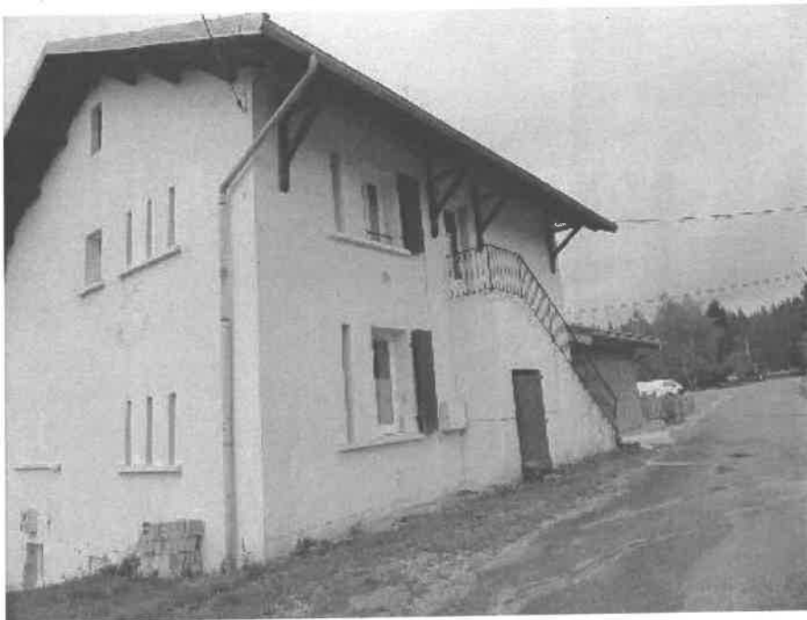
Escalier de secours R+1 (locaux à sommeil)
